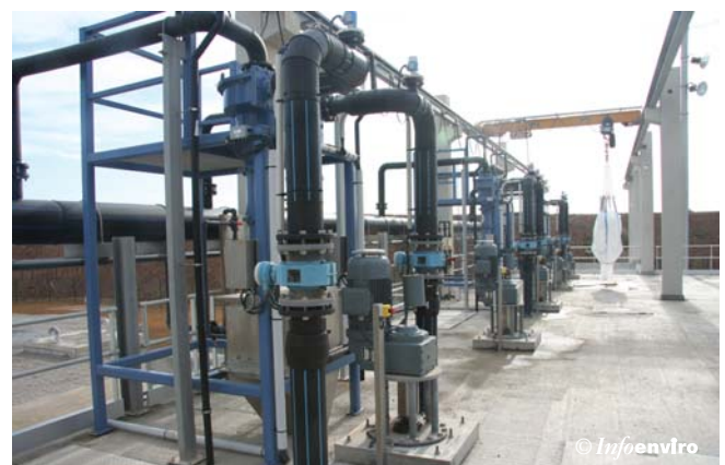
Vista de los depósitos de reactivos suministrados por Plavisa
