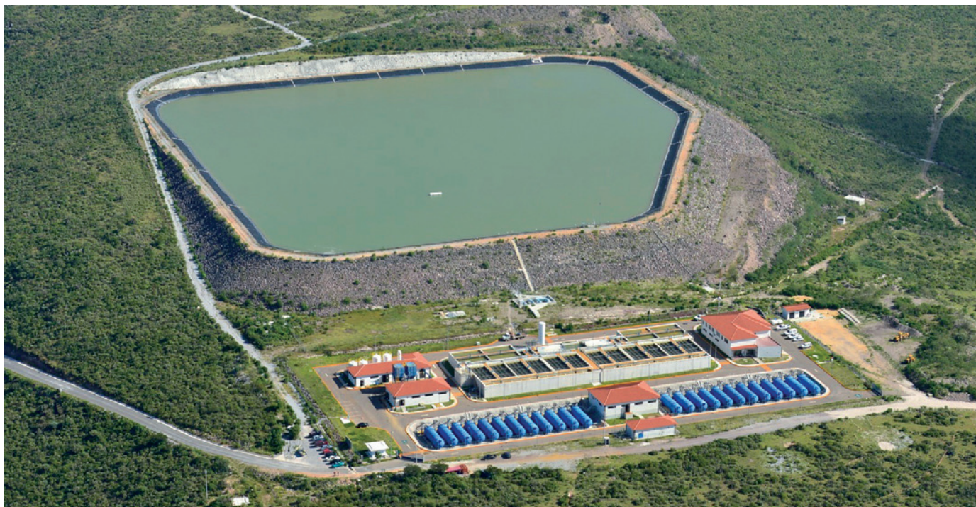
Acueduto e estação de tratamento de água Acueducto II, México.
