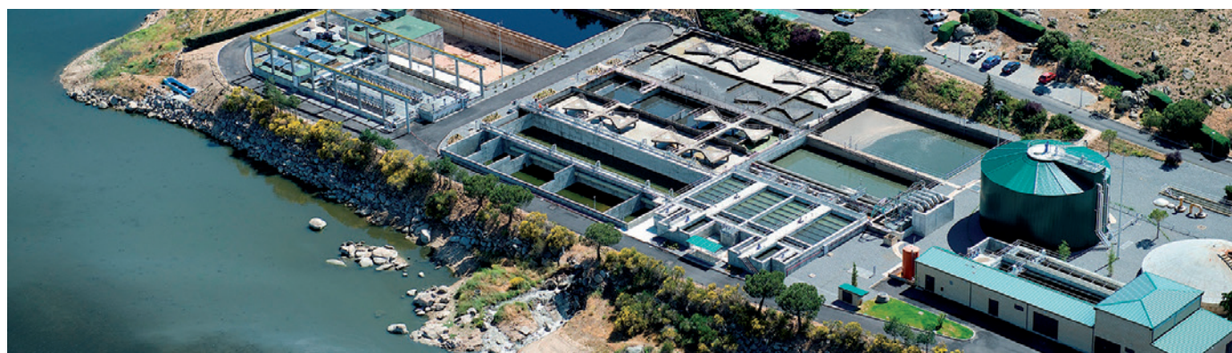
Vista aérea da ETAR de Ávila.
