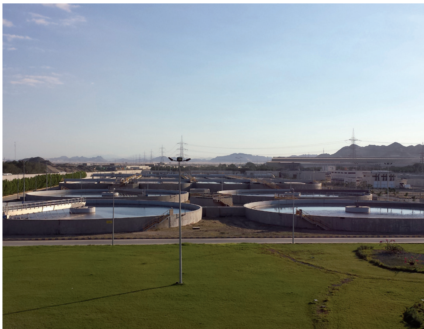
Estação de tratamento de águas residuais em Meca.
