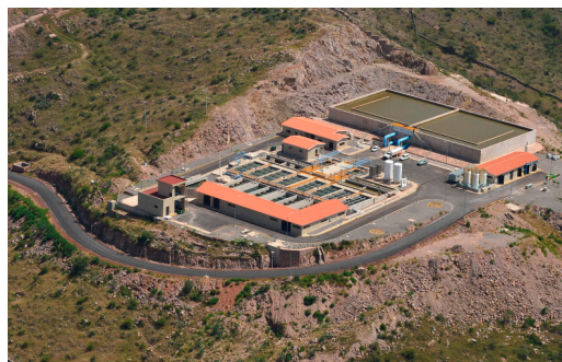
A estação de tratamento de água (ETA) (México)
