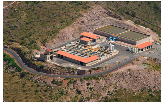
La station d'épuration d'El Realito (Mexique)
